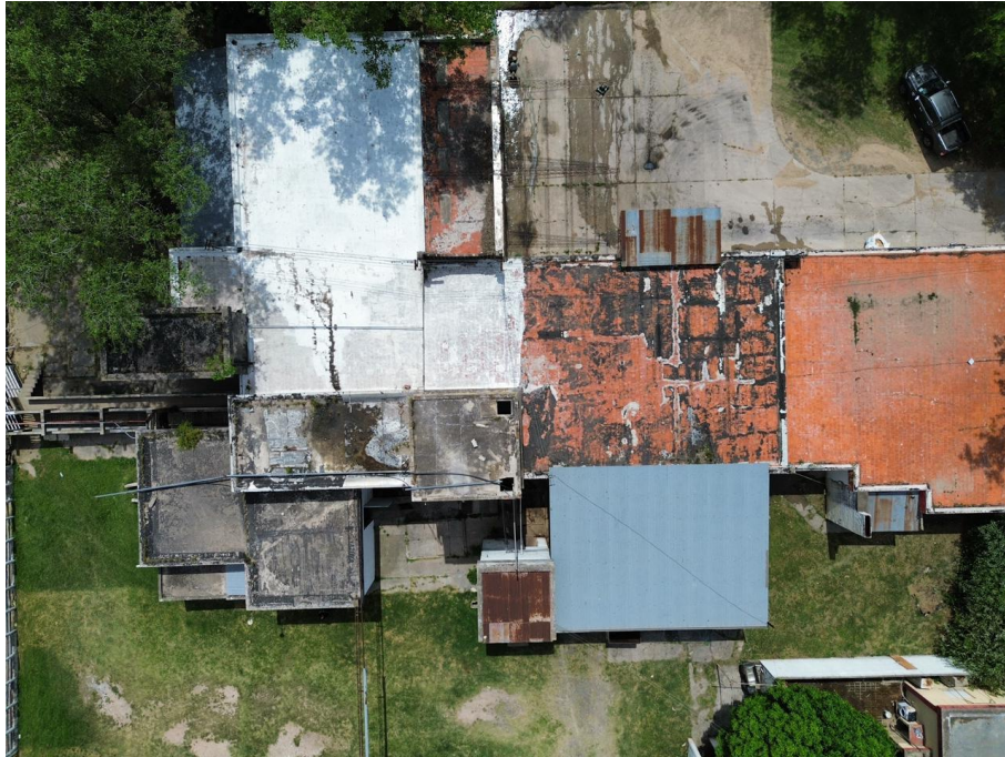
Techos del conjunto
